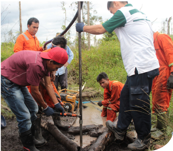
Pembangunan sumur bor merupakan salah satu upaya untuk mencegah kebakaran di wilayah Kalimantan Tengah.
