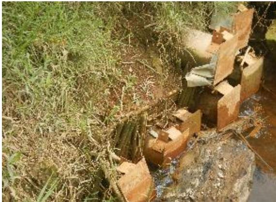
**Gambar 4. Saluran pembuangan kanal yang tidak terawat**
